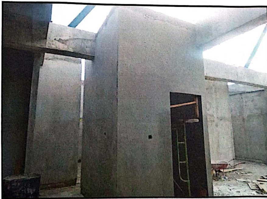
PEKERJAAN PLESTERAN DAN ACIAN DINDING
