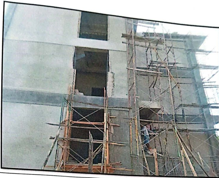
PEKERJAAN PLESTERAN DAN ACIAN DINDING
