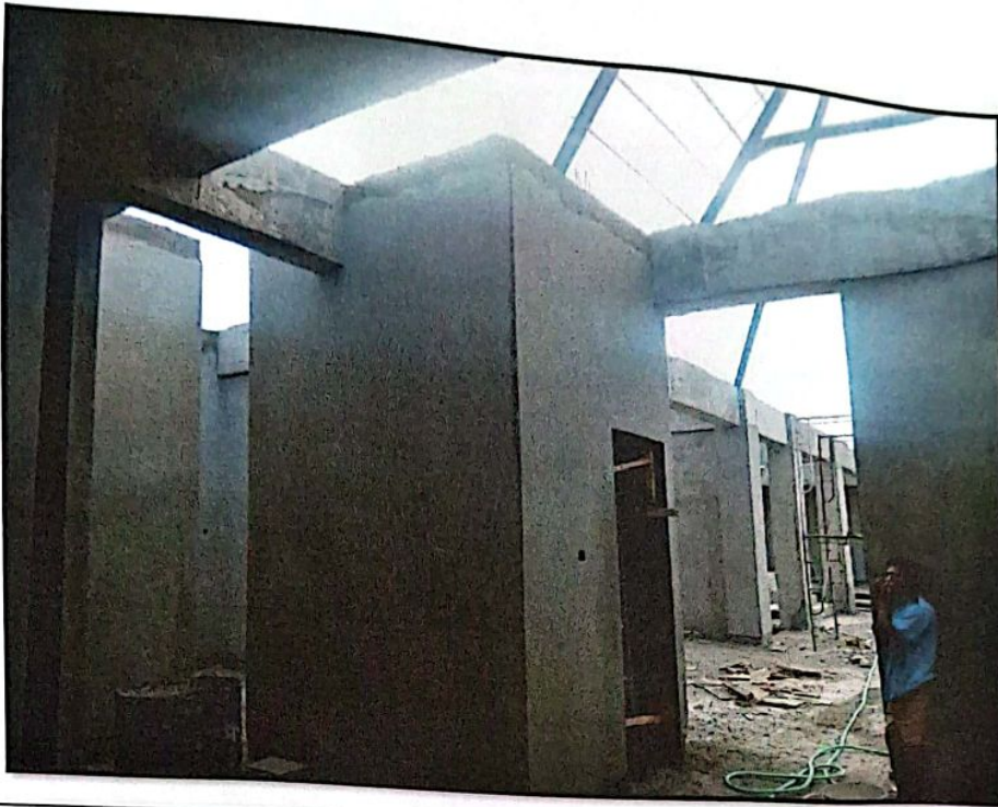
PEKERJAAN PLESTERAN DAN ACIAN DINDING
