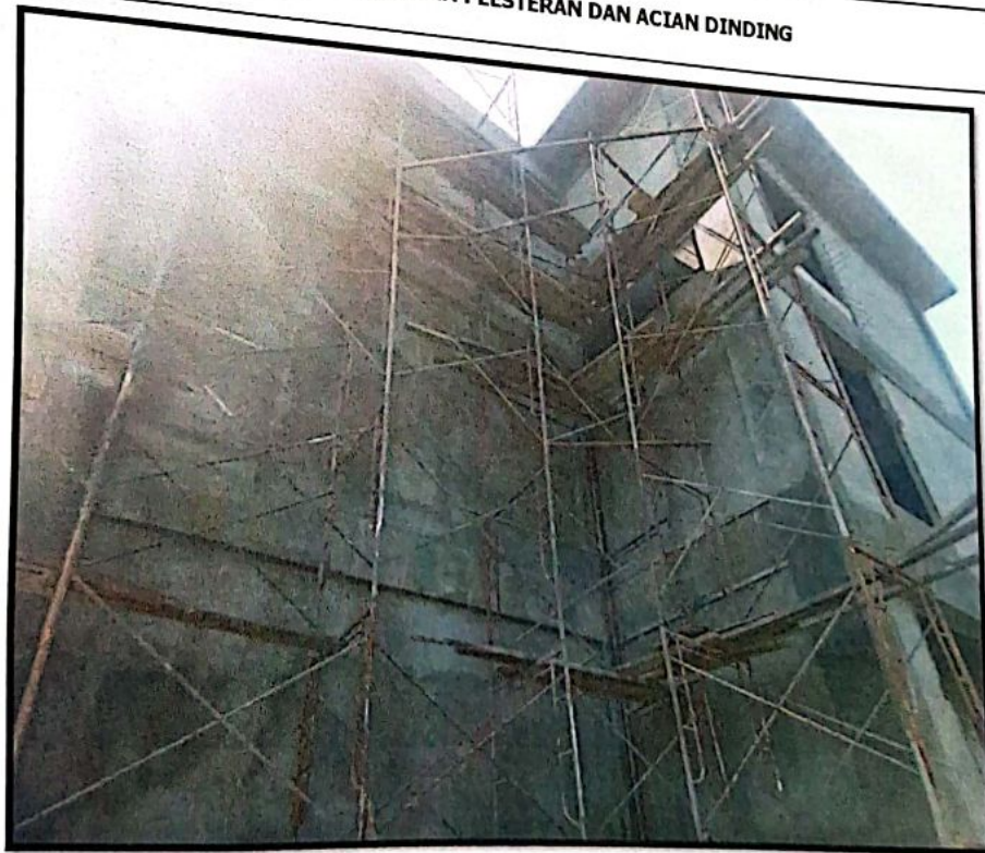
PEKERJAAN PLESTERAN DAN ACIAN DINDING
