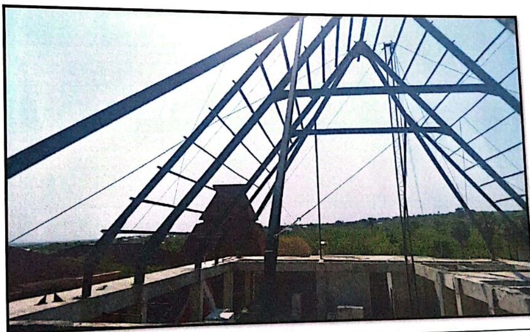
PEKERJAAN WF RAGKA ATAP WF
