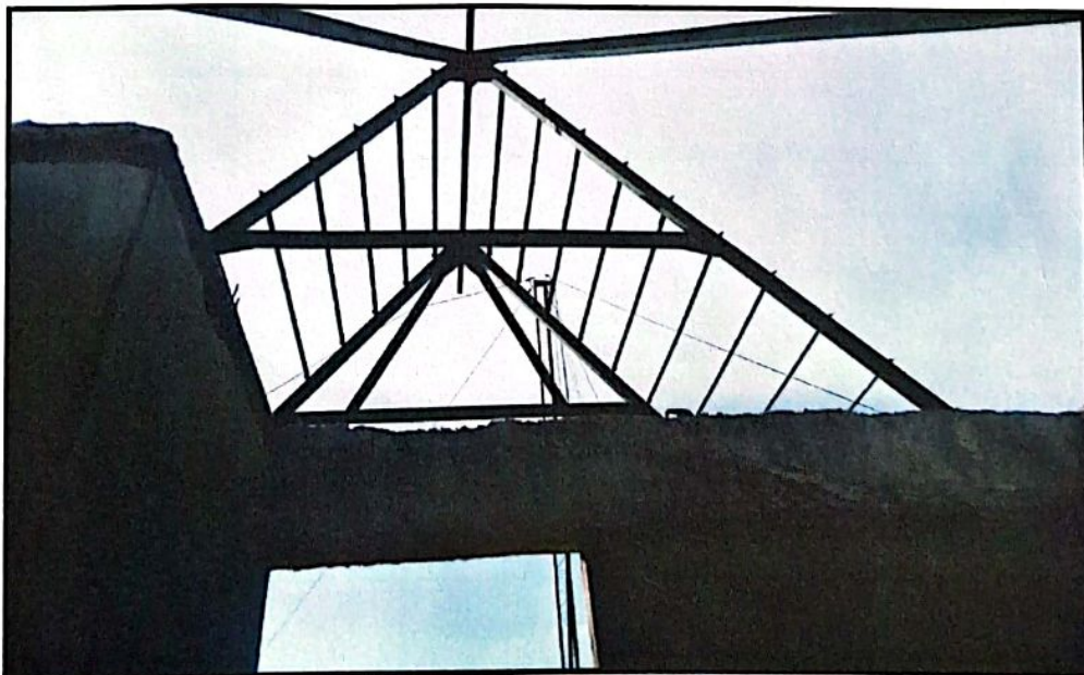
PEKERJAAN WF RAGKA ATAP WF
