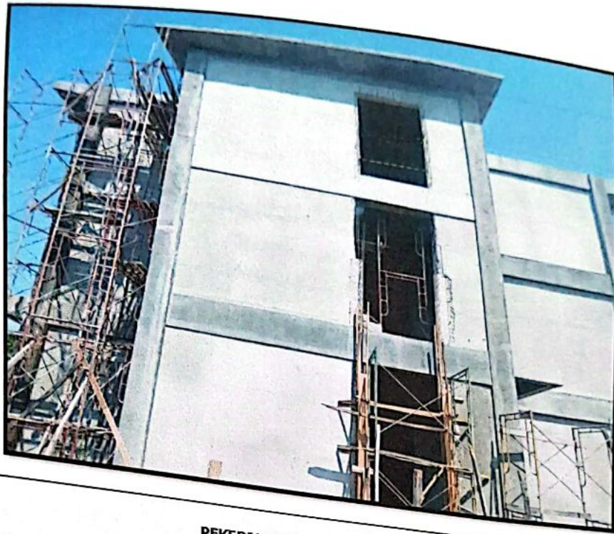
PEKERJAAN PLESTERAN DAN ACIAN DINDING
