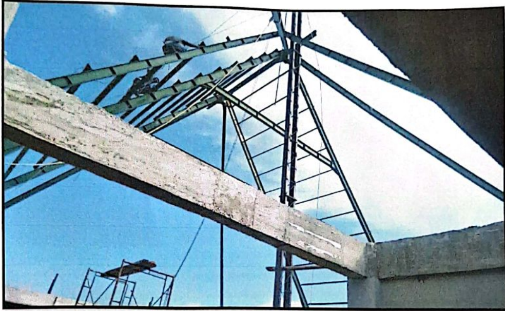
PEKERJAAN WF RAGKA ATAP WF
