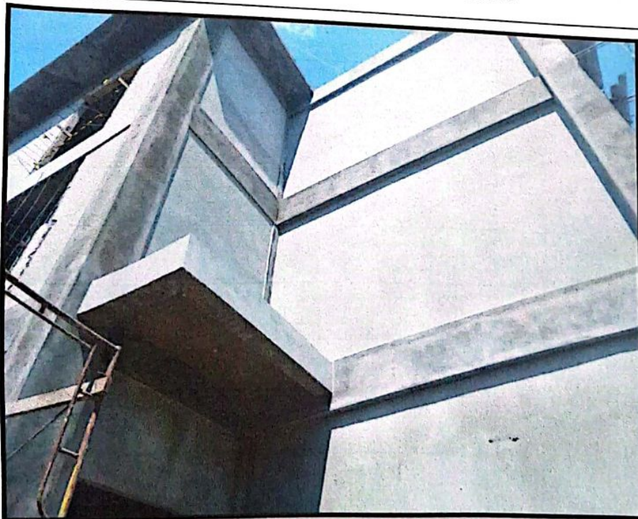
PEKERJAAN PLESTERAN DAN ACIAN DINDING
